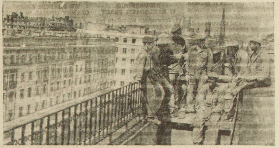
Naradę murarską najlepiej zrobić na miejscu pracy. Tym razem wypadło to akurat na dachu wysokiego bloku MDM-u. Wygodne siedzenia to kominy, a wokół — wspaniałe widoki Warszawy, stolarskich, betonarskich...
