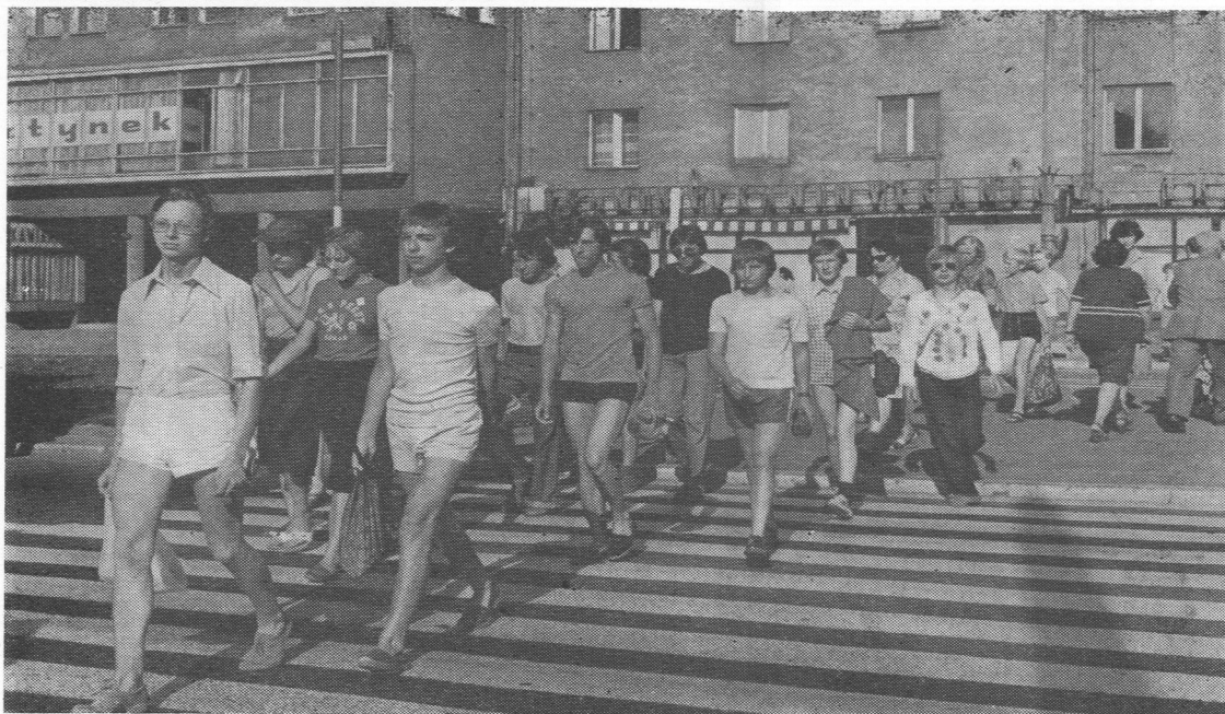
Chłopcy dobrze poznali już ulice Gdyni, sami wybierają się na przechadzkę
