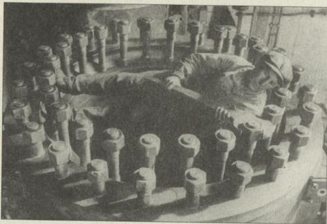
Mécanicien goujonnant un cylindre de moteur électrique, Mulhouse 1932.
