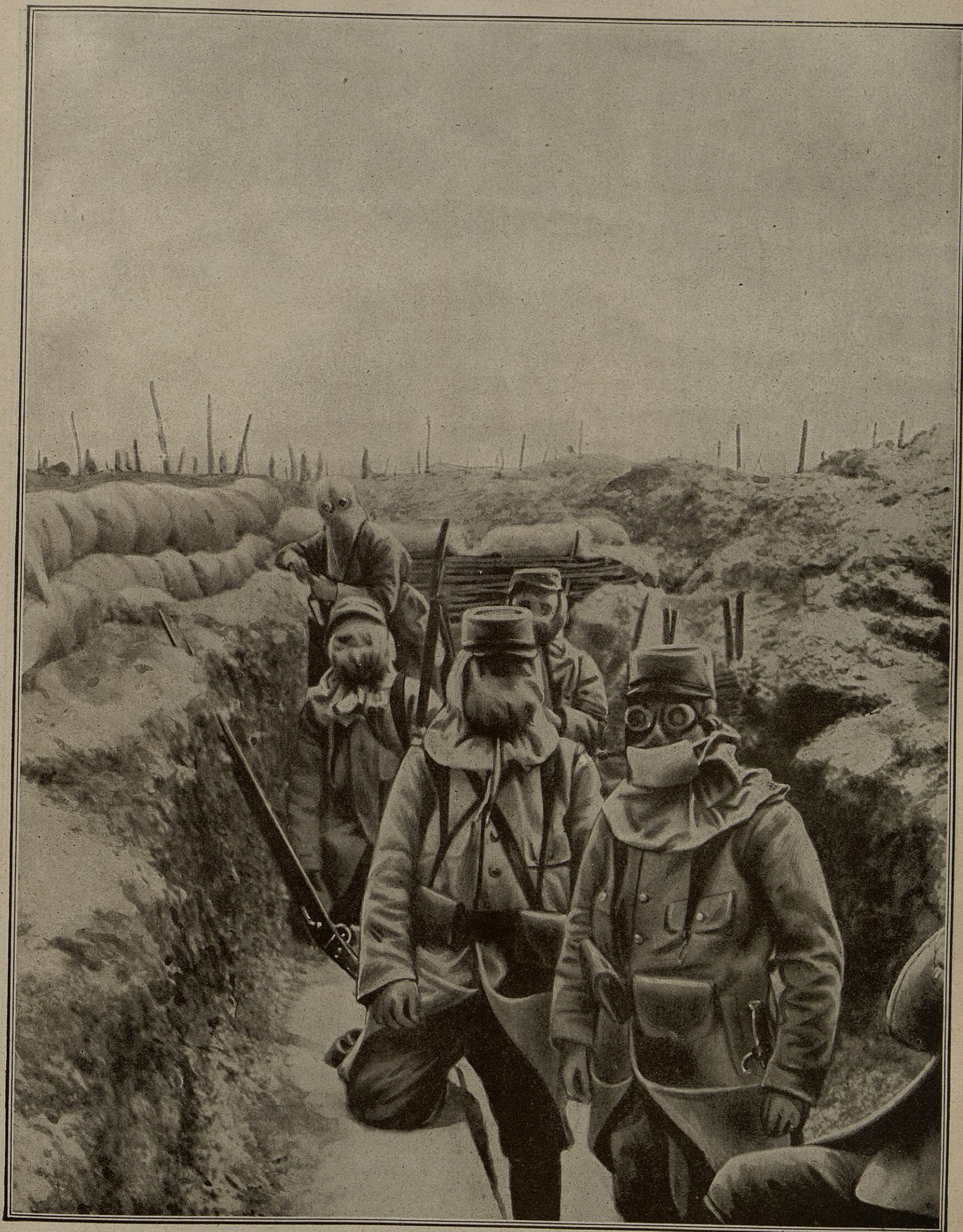
Voici l'aspect extraordinaire que présente l'une de nos tranchées lorsque les soldats qui l'occupent ont mis les masques protecteurs contre les gaz asphyxiants ; cette photographie donne en même temps une vue des défenses extérieures de la tranchée : parapets formés de sacs remplis de terre, poteaux qui soutiennent le réseau de fil de fer.
