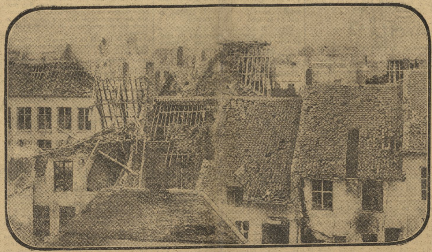
LES TOITS CREVÉS PAR LE BOMBARDEMENT Photo PETITE GIRONDE
