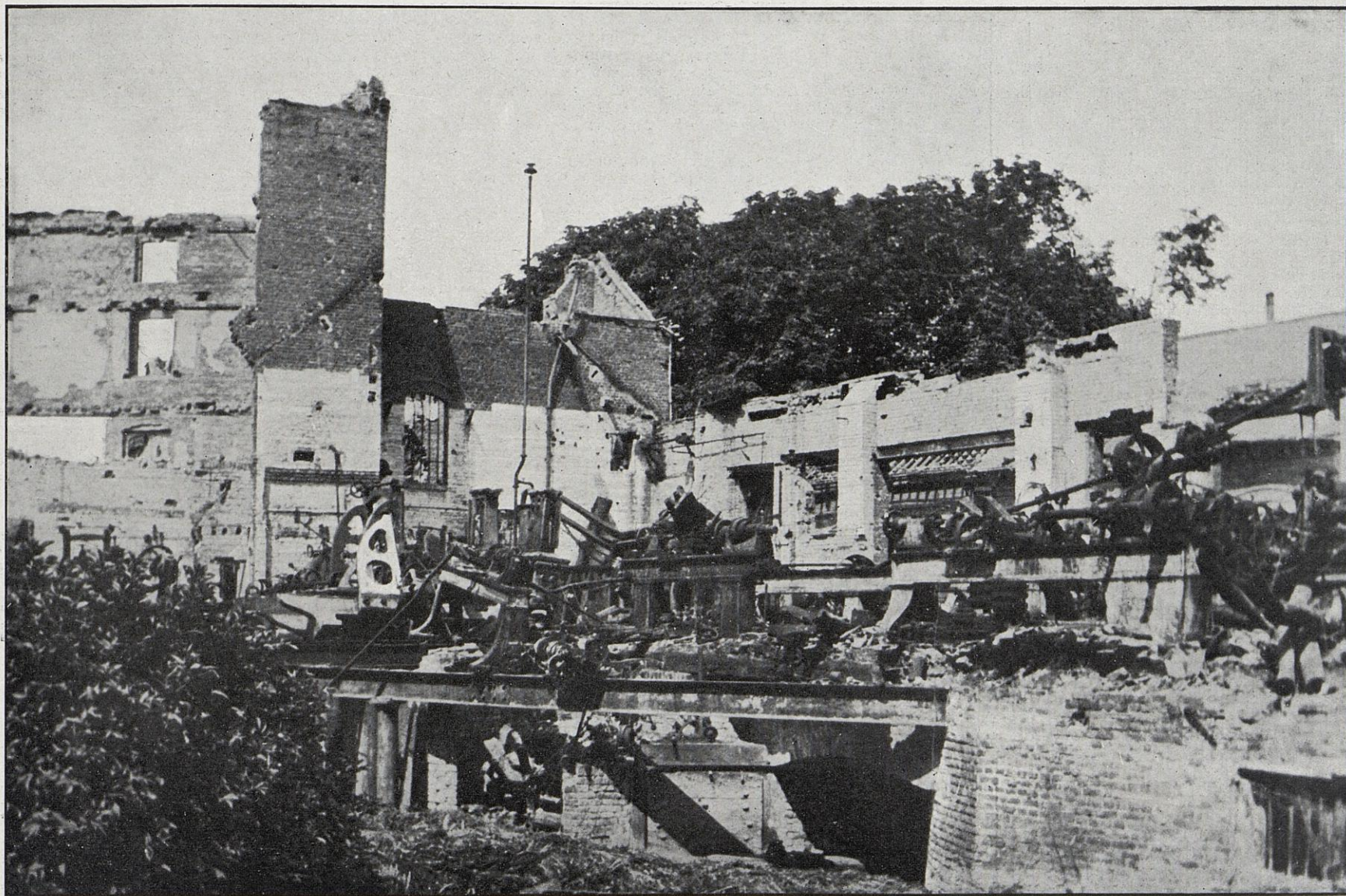
Les ateliers de constructions d'Albert bombardés et ruinés par les Allemands.
