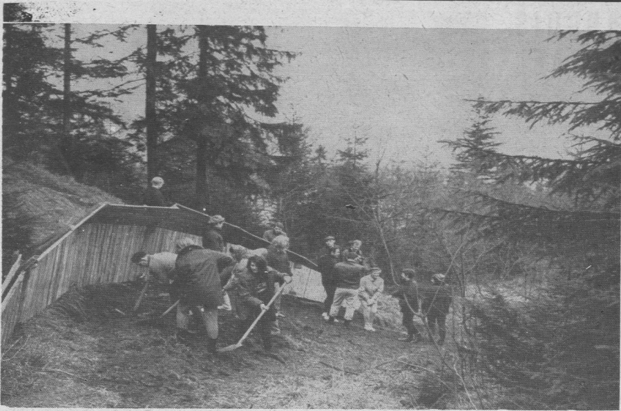
Tu... wra praca przy budowie toru saneczkowego — na stoku Krokwi
