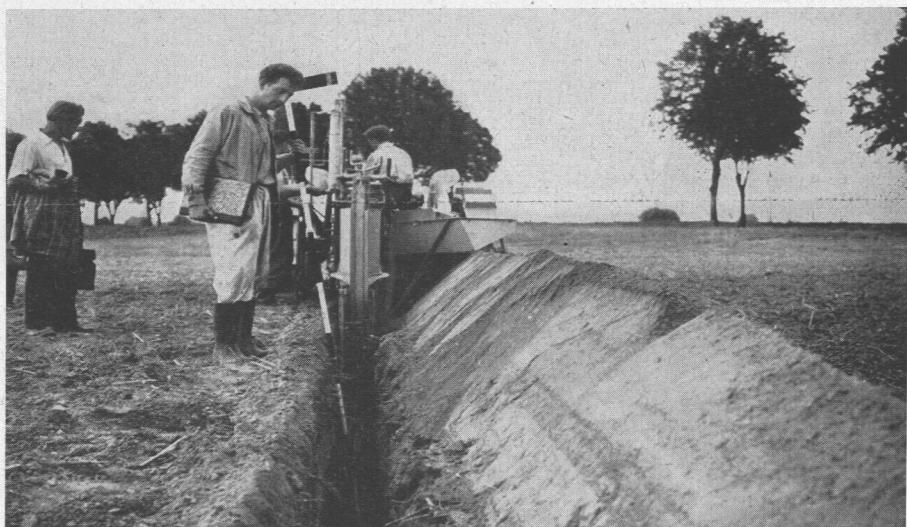
Na polskiej wsi prowadzi się na wielką skalę roboty melioracyjne. Na zdjęciu drenowanie gruntów w Jabłonkowie.
