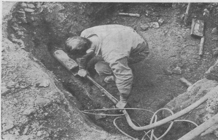
Uwaga! Kret natrafił na rozmokłą glinę. Do rury wciągniętej już prawie całkowicie dołącza się drugiego Kreta, który dopomoże swemu „bratu” do wydobycia się z trudnego terenu. Wspólnymi siłami dokończą dzieła
