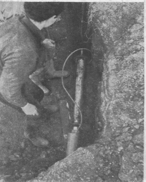
Grunt został przebity i rury założone. Po przeciągnięciu przewodów zasypuje się doły — praca skończona. Przez cały czas ruch kolejowy trwał nieprzerwanie. I na tym właśnie polega największa wartość Kreta — tworzy polskich konstruktorów
