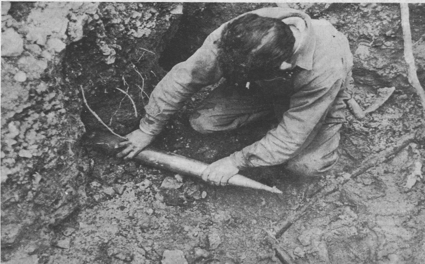
Zadanie zostało wykonane szybko i pomyślnie: Kret wyszedł spod ziemi po drugiej stronie torowiska bez przeszkód
