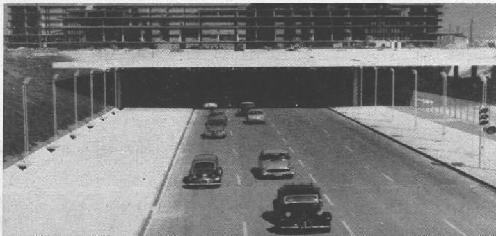
Na szosie nr 7 przebito tunel pod lotniskiem Orly, ażeby usprawnić ruch na tej ważnej arterii.
