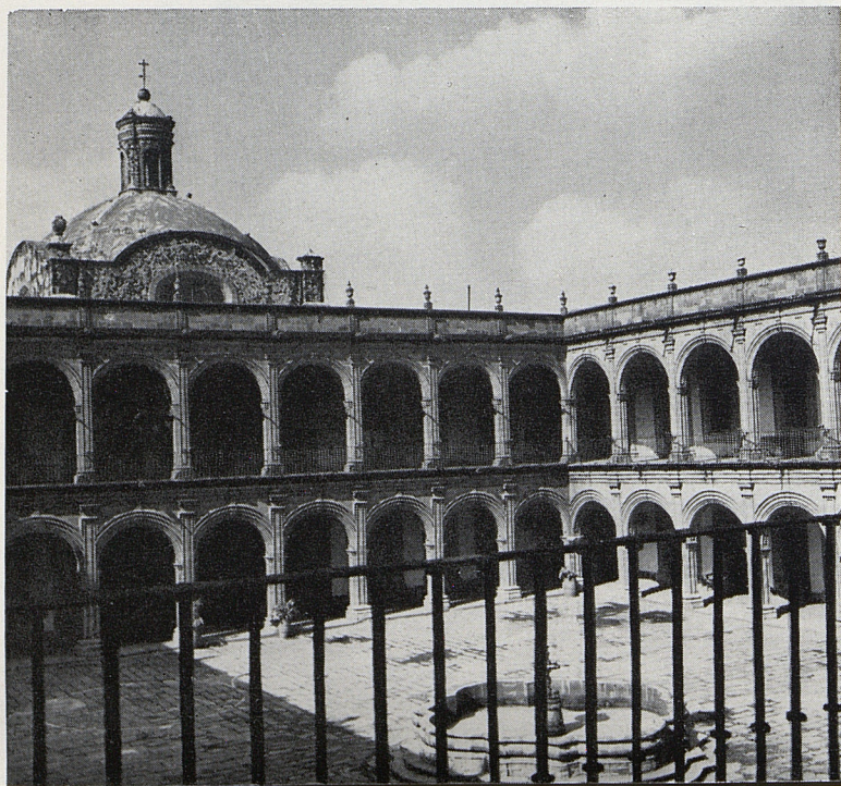
Le patio principal et le dôme de l'escalier monumental
