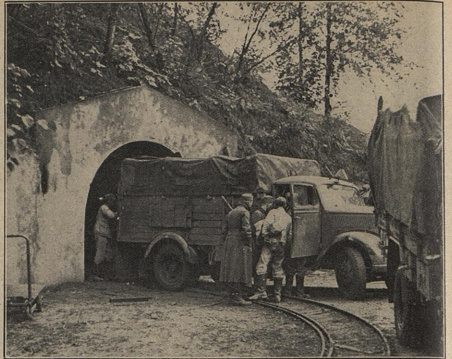
Deutsche Soldaten entdeckten durch Zufall diesen vermauert gewesenen Tunnelleingang. Hinter ihm tat sich ein ausgedehntes System von Lagerhallen und Verbindungsgängen auf: Ein ungeheures Rohstofflager der Polen war gefunden!
