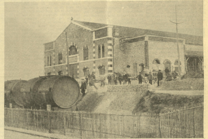
Coopérative de Maurausan (Hérault), 1905 : l'édification de ce superbe immeuble a marqué une étape glorieuse dans l'histoire de la coopération agricole d'avant-garde.
