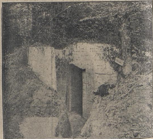
Beton-Unterstand im Wald.
