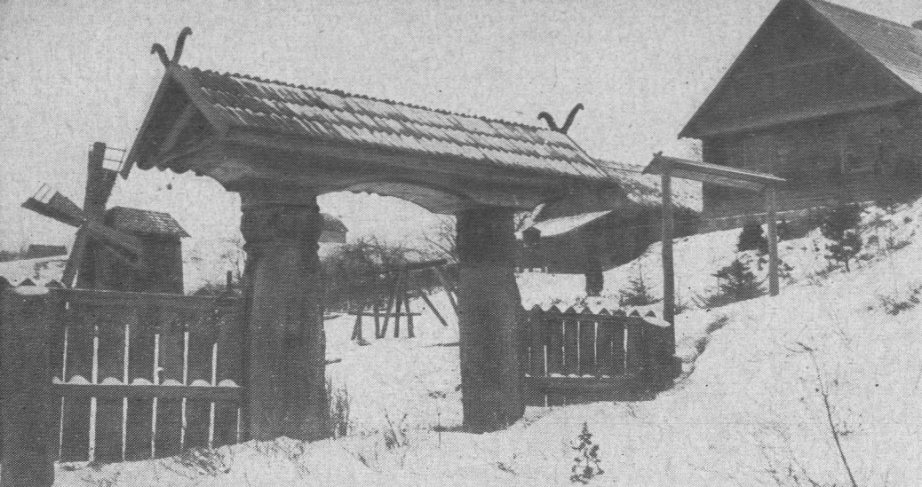
Tak wygląda brama wjazdowa „skansenu” kurpiowskiego w Nowogrodzie nad Narwią. Z lewej — wiatrak, z prawej — chata i stodoła
