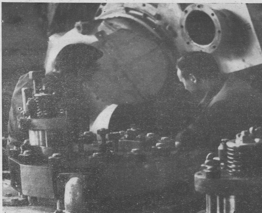
Montaż silnika sulzerowskiego.
