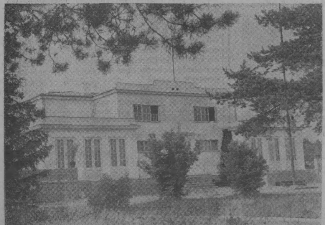
Kolonie letnie Zakładów Mechanicznych Ursus mieszczą się w pięknym, eleganckim domu fabrycznym, zbudowanym wśród sosnowego lasu. Przed przyjazdem dzieci, dom ten został specjalnie odświeżony.
