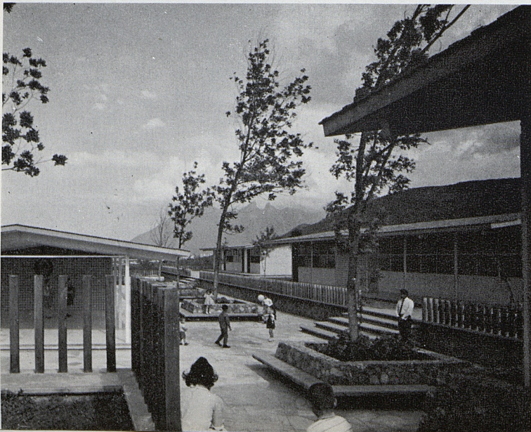
Ecole primaire de Monterrey.
