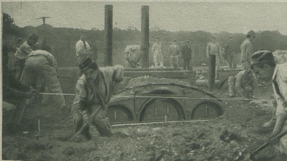
ON INSTALLE LES FOURS
