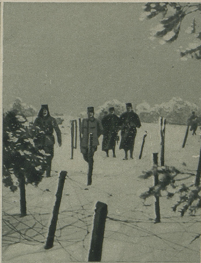
EN AVANT DES TRANCHÉES
