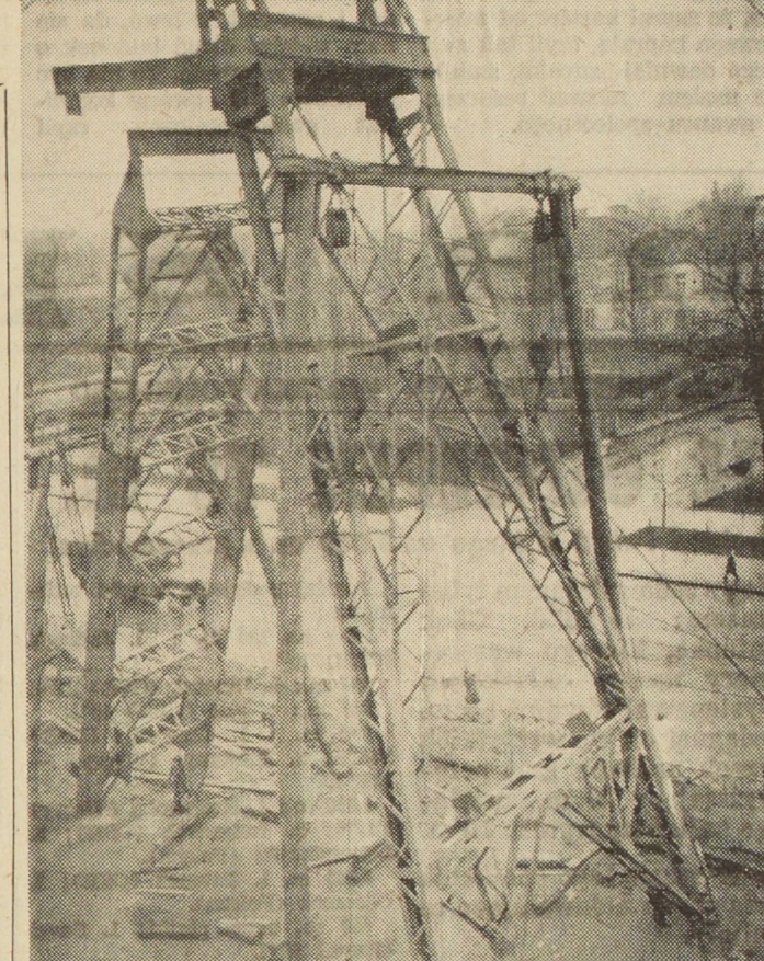
Już w końcu Planu 6-letniego zostanie oddana do użytku pierwsza linia metra. Na zdjęciu: Nad wykończonym już sztybem stawia się wieżę wyciągową. Przy ich pomocy wydobytą z chodnika ziemię wywozi się na powierzchnię
