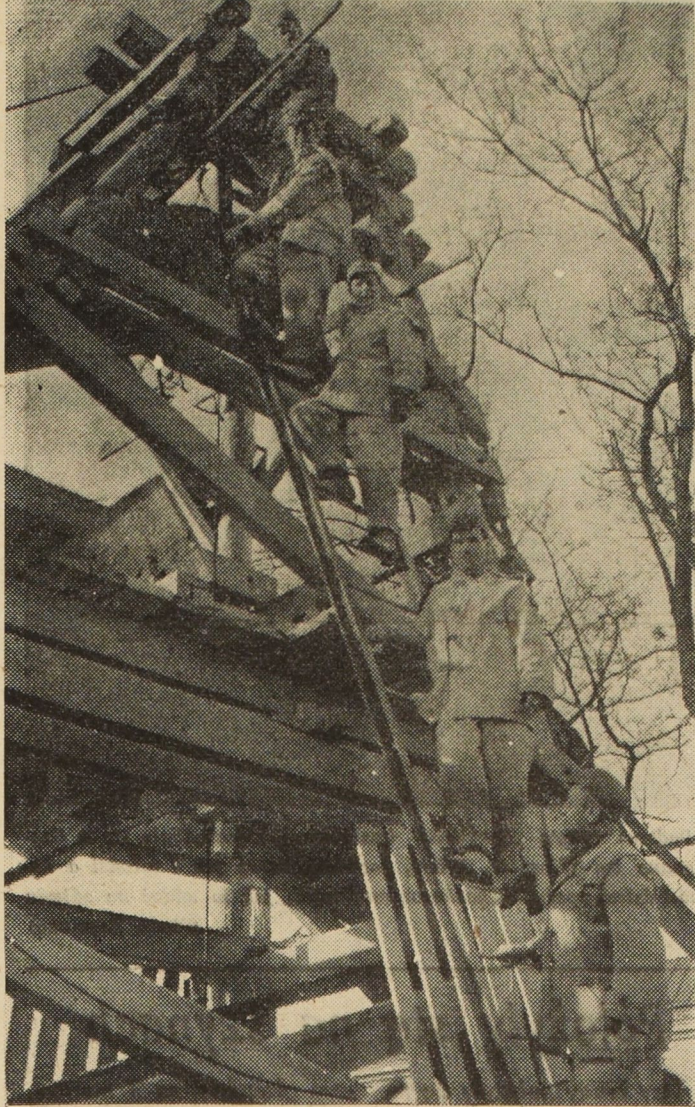
Przy budowie metra, część prac szybowych wykonują wykwalifikowani górniczy śląscy
