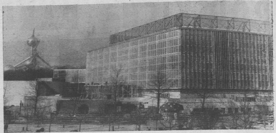
Zbliża się termin otwarcia światowej Wystawy w Brukseli. Na zdjęciu pawilon ZSRR wykonany z metalu i ze szkła.
