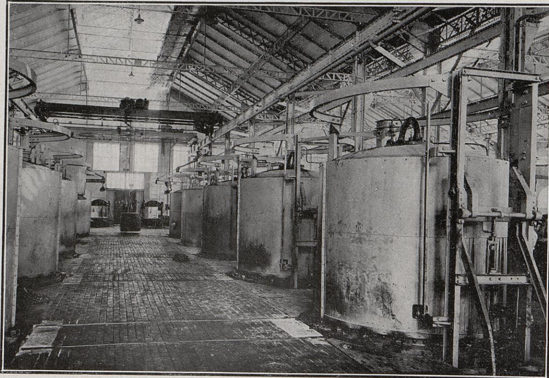
Quelques autoclaves pour bandages de poids lourds. (On aperçoit une série de bandages transportés par un pont roulant et arrivant à la cuisson qui durera cinq heures environ.)
