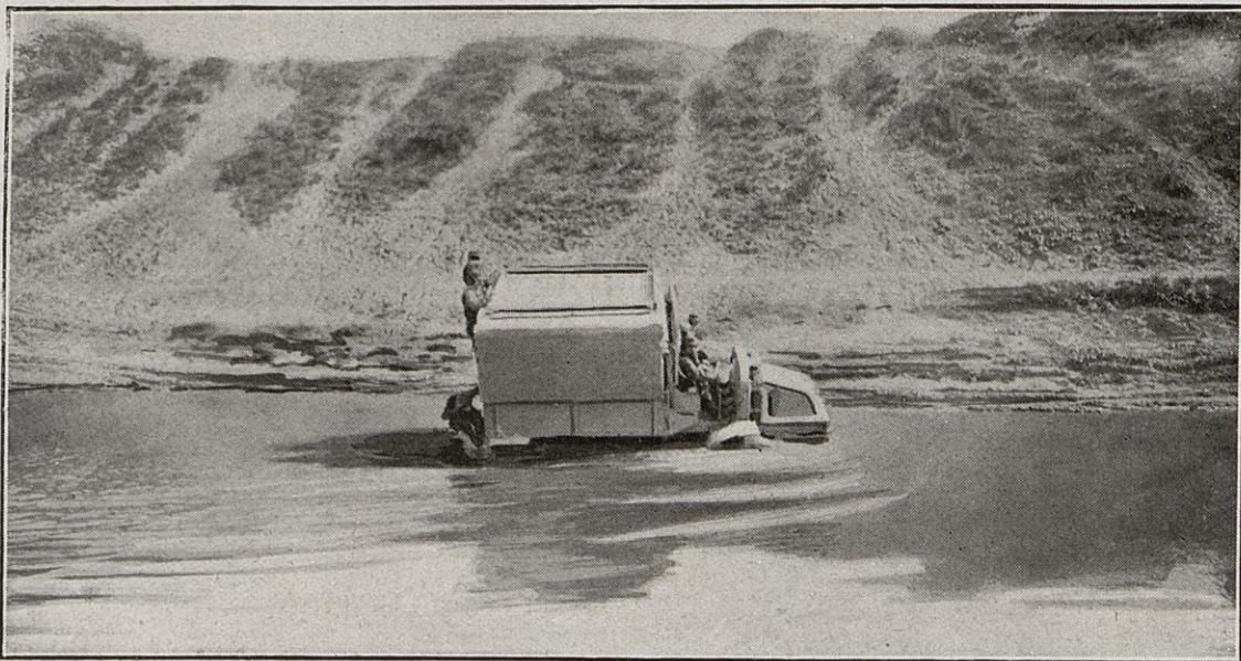
Tracteur Latil franchissant un gué. (Il a laissé sur la rive, pour ce passage difficile, une remorque de 15 tonnes qu'il halera ensuite grâce à son cabestan.)
