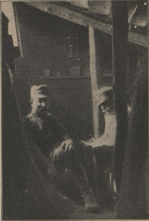
In einer Erdhöhlen-Wohnung der österr.-ungarischen Truppen in Galizien.
