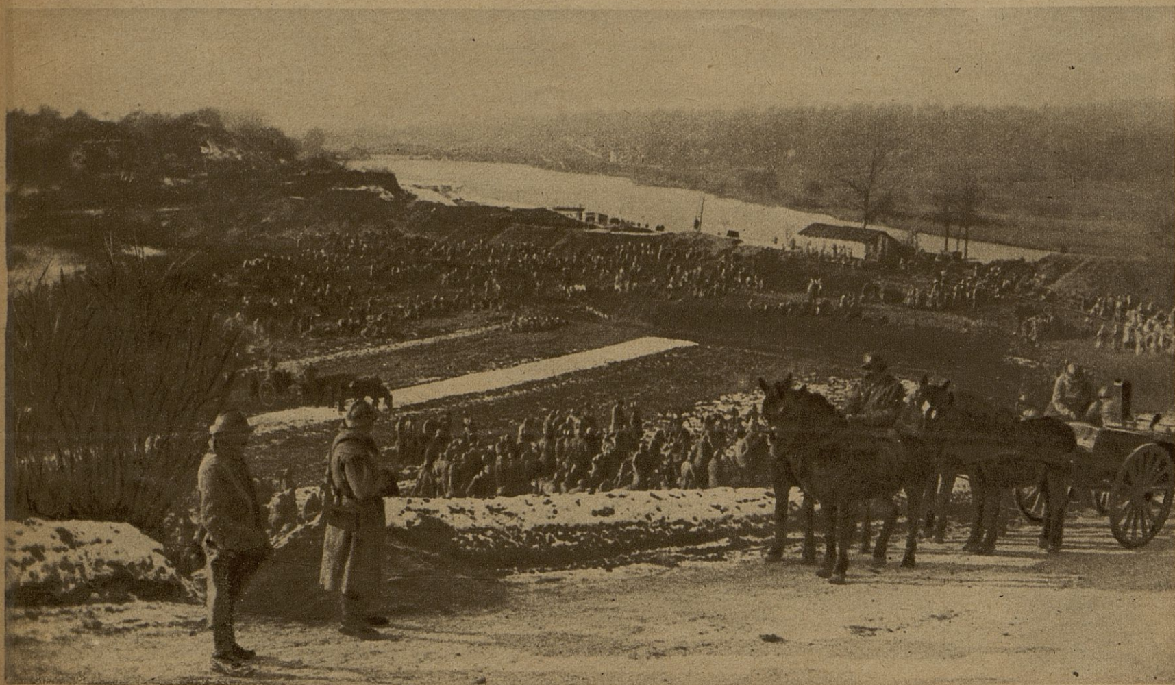
Des opérations au nord de Toul ont récemment nécessité l'établissement sur la Moselle d'un pont de bateaux, que notre photographie montre en cours de construction. Le génie, avec l'aide des troupes, principalement des territoriaux, s'acquitte avec une rapidité incroyable des travaux de ce genre. Les ponts de bateaux permettent le passage de troupes nombreuses, avec leurs convois, leur artillerie, leur cavalerie ; ils offrent l'avantage de pouvoir être coupés aussi promptement que construits ou rétablis.
