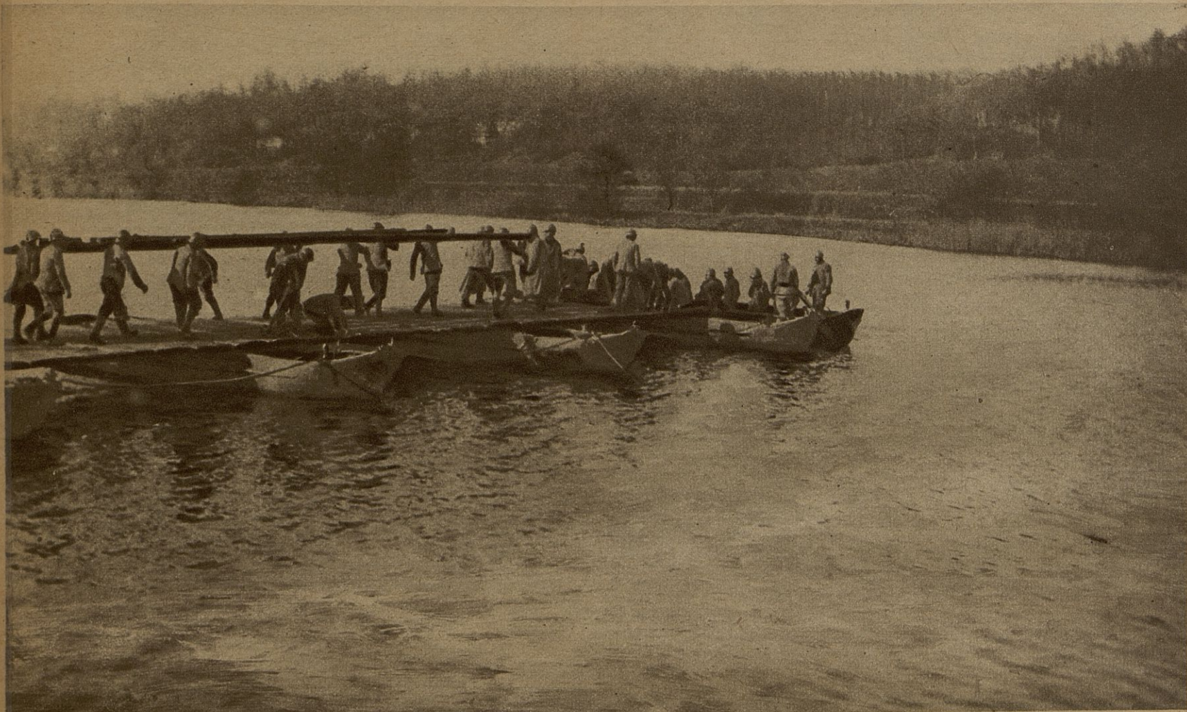
Des opérations au nord de Toul ont récemment nécessité l'établissement sur la Moselle d'un pont de bateaux, que notre photographie montre en cours de construction. Le génie, avec l'aide des troupes, principalement des territoriaux, s'acquitte avec une rapidité incroyable des travaux de ce genre. Les ponts de bateaux permettent le passage de troupes nombreuses, avec leurs convois, leur artillerie, leur cavalerie ; ils offrent l'avantage de pouvoir être coupés aussi promptement que construits ou rétablis.
