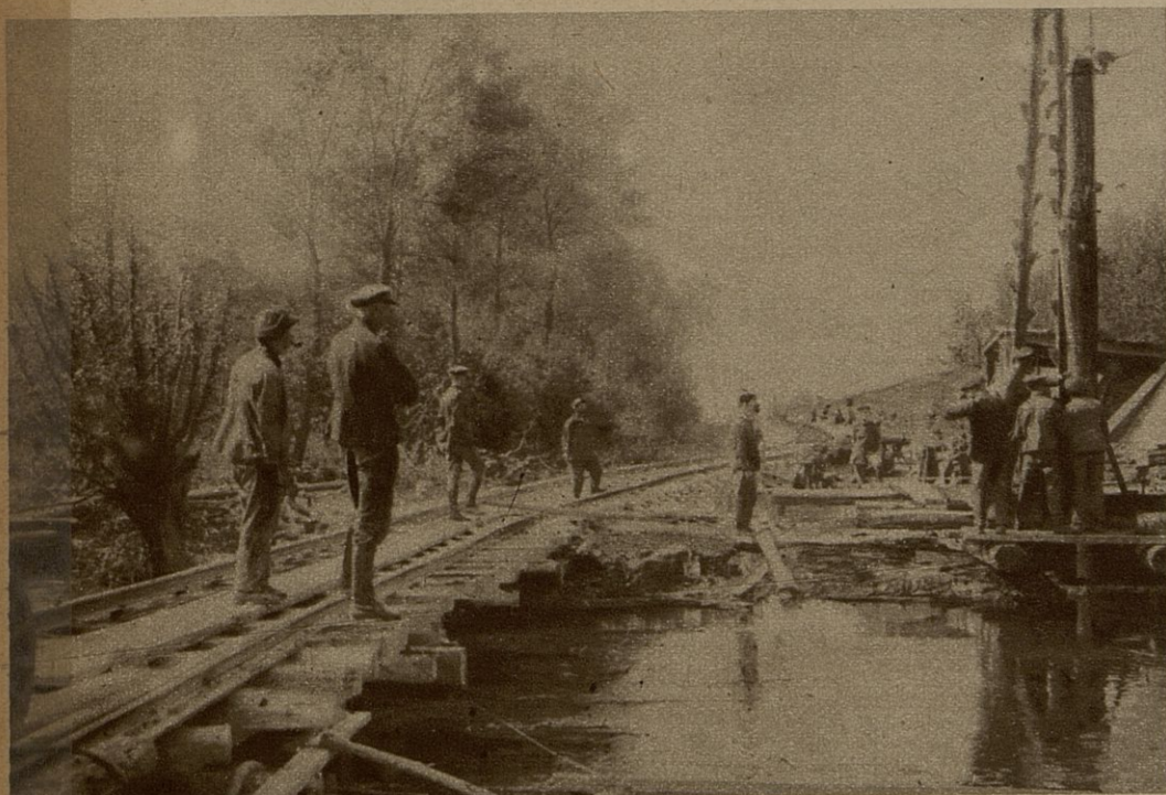
Passerelle provisoire établie sur le canal de la Somme pour le passage de la voie ferrée construite par le génie belge sur le front français.
