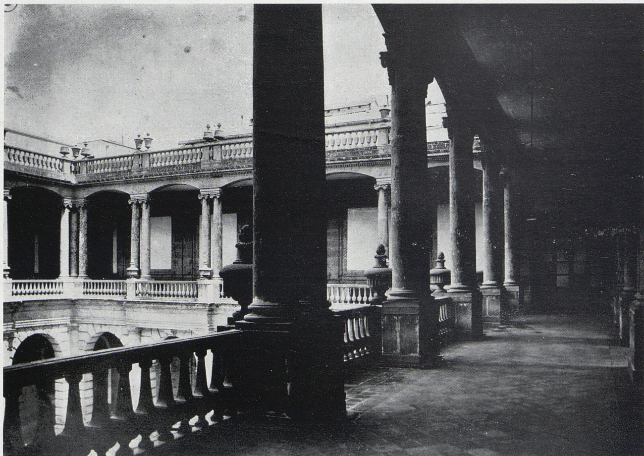
Une galerie du Palais des Mines.
