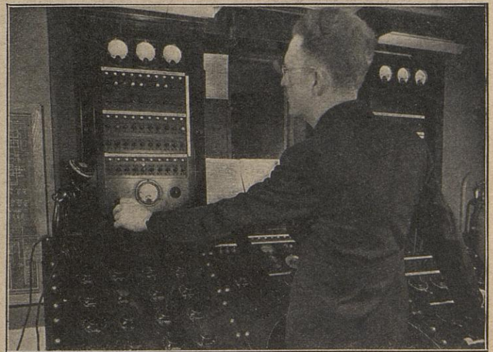
Eine Lautsprecheranlage in der Kirche.
