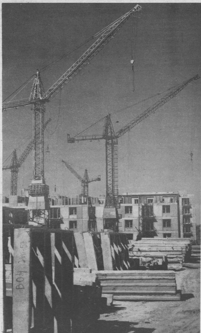
Nowe bloki na Kole w Warszawie (zdjęcie u góry) oraz osiedle Wierzbno w budowie.
