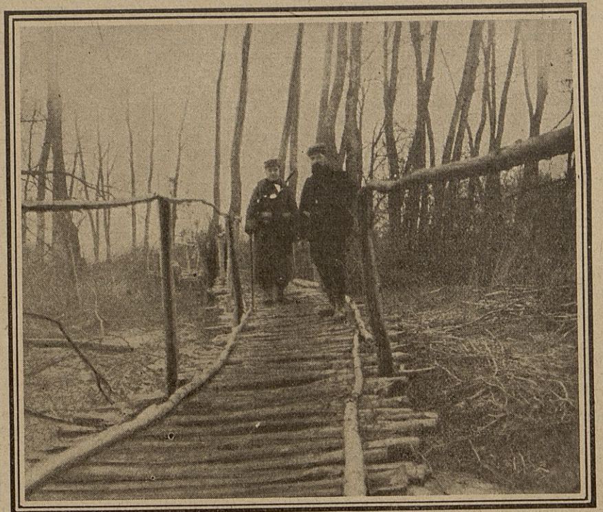
La pluie et la neige ont grossi les ruisseaux qui courent le long des bois lorrains ; des passerelles faites avec des troncs d'arbres et munies de garde-fous sont assez solides pour permettre la traversée aux troupes qui opèrent dans cette région.
