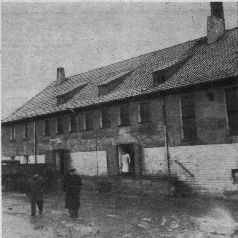
Nowe Zakłady Mleczarskie, wybudowane w Rychwale po wojnie nie są co prawda żadną konkurencją dla wielkiego przemysłu węglowego, ale zatrudniają kilkudziesięciu pracowników z pobliskiej okolicy
