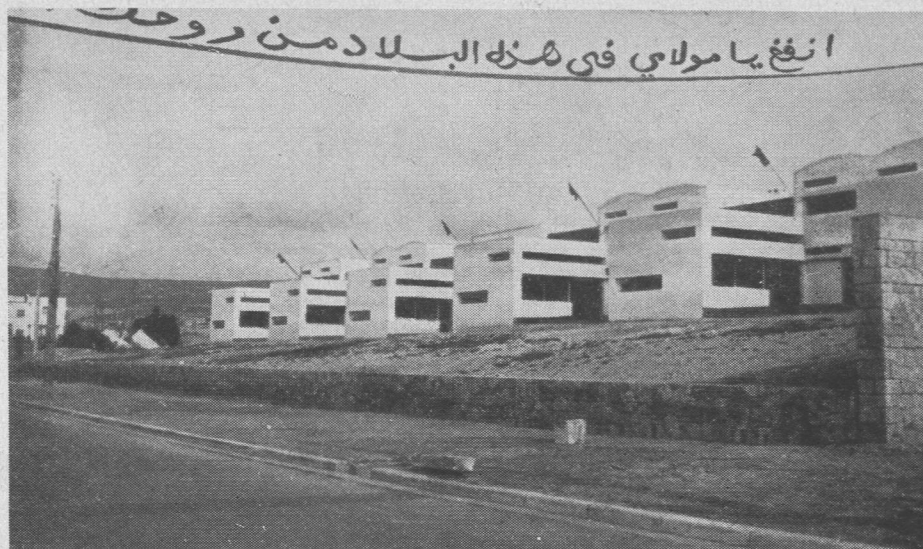
W roku 1960 miasto Agadir (południowe Maroko) zostało dotknięte straszliwym trzęsieniem ziemi, które spowodowało śmierć 30 tysięcy ludzi i zniszczenie całego miasta. Po pięciu latach wiele dzielnic jest już prawie całkowicie odbudowanych. Na zdjęciu: fragment nowej dzielnicy willowej Agadiru
