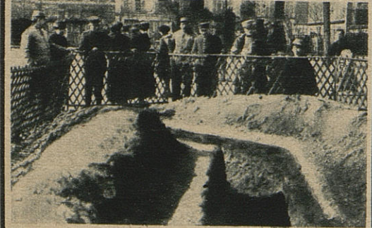
Les précautions contre les gothas. — A Vincennes, la municipalité fait creuser des tranchées-abris modèles.
