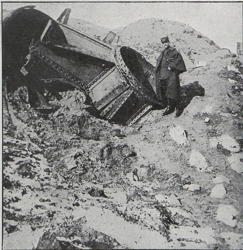
Une coupole du fort de Manonviller arrachée par l'explosion d'un obus.
