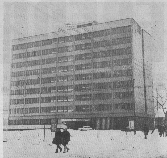
Ten nowoczesny biurowiec Zakładu Urządzeń Przemysłowych w Nysie wybudowano dwa lata temu. Tu wszystko jest nowe!
