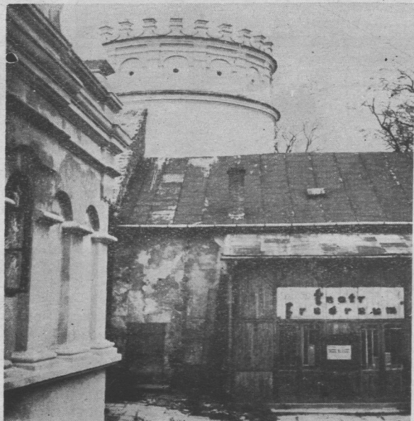
Budynek Teatru „Fredreum” w Przemyślu
