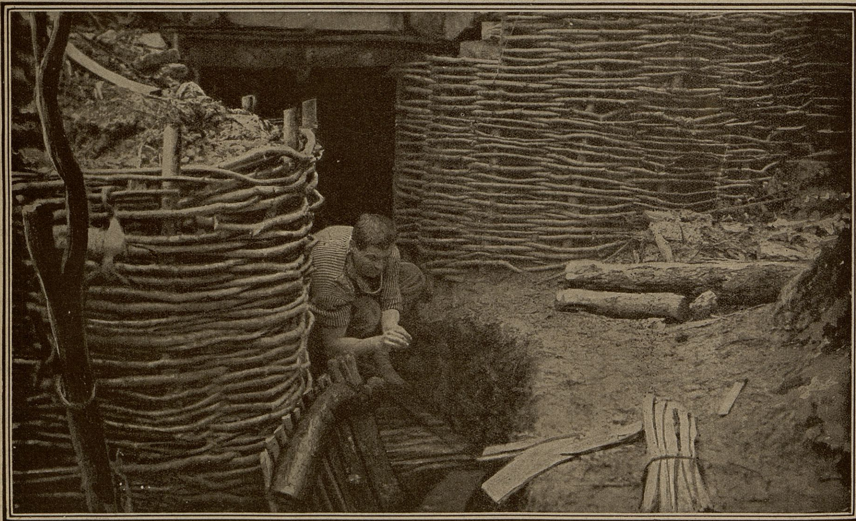
Dans les tranchées nos soldats ont beaucoup souffert de la pluie et de la boue ; ils ont pataugé dans les terres détrempées. L'entrée de cet abri a dû être clayonnée pour éviter les éboulements, et le fond du boyau qui y conduit est couvert par des rondins.
