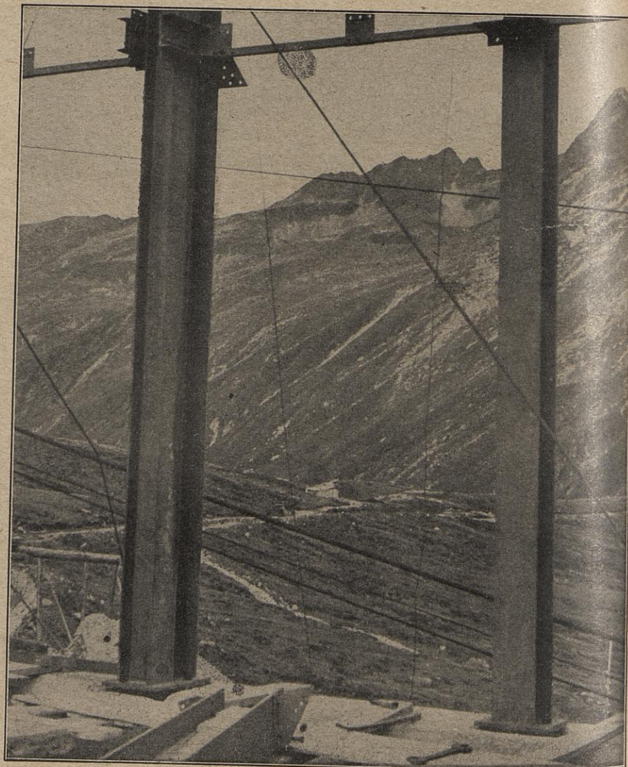
Ein Blick durch die Baugerüste auf die grandiose Alpenwelt. Das Bauvorhaben wird die natürliche Wasserscheide Donau-Rhein an dieser Stelle völlig befertigen! Durch einen drei Kilometer langen Stollen wird das bewirkt.
