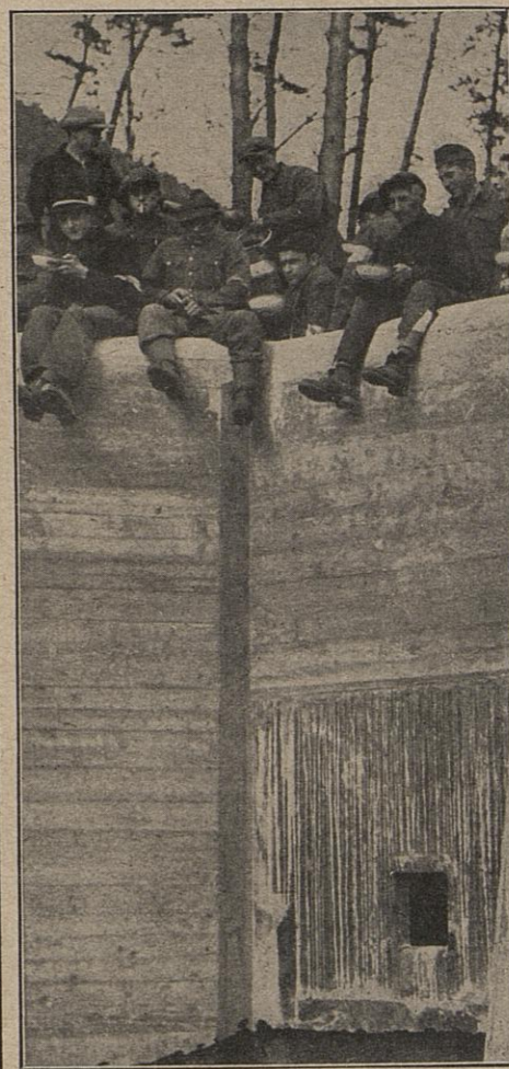
Essenpause: Zur Verpflegung auf der Baustelle gehört auch die warme „Buntersuppe“. Alle Aufnahmen: Gronefeld
