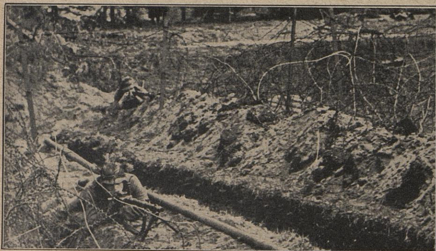
Um die Baustelle gegen Handstreiche zu schützen, liegt — wohlgetarnt — im Stachelndraht ein MG.
