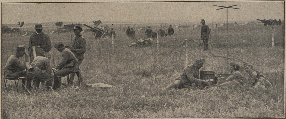
14. ... bis zur Befehlsstelle dicht bei den Batterien.
