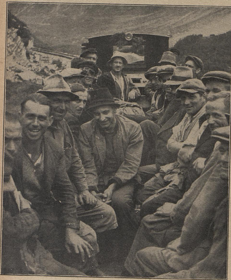
Der „Silvretta-Express“ bringt jeden Morgen die Arbeitskameraden an ihre Arbeitsplätze. Hoch oben in der alpinen Welt wurden für dieses Bauvorhaben fast 30 Kilometer Gleise verlegt.
