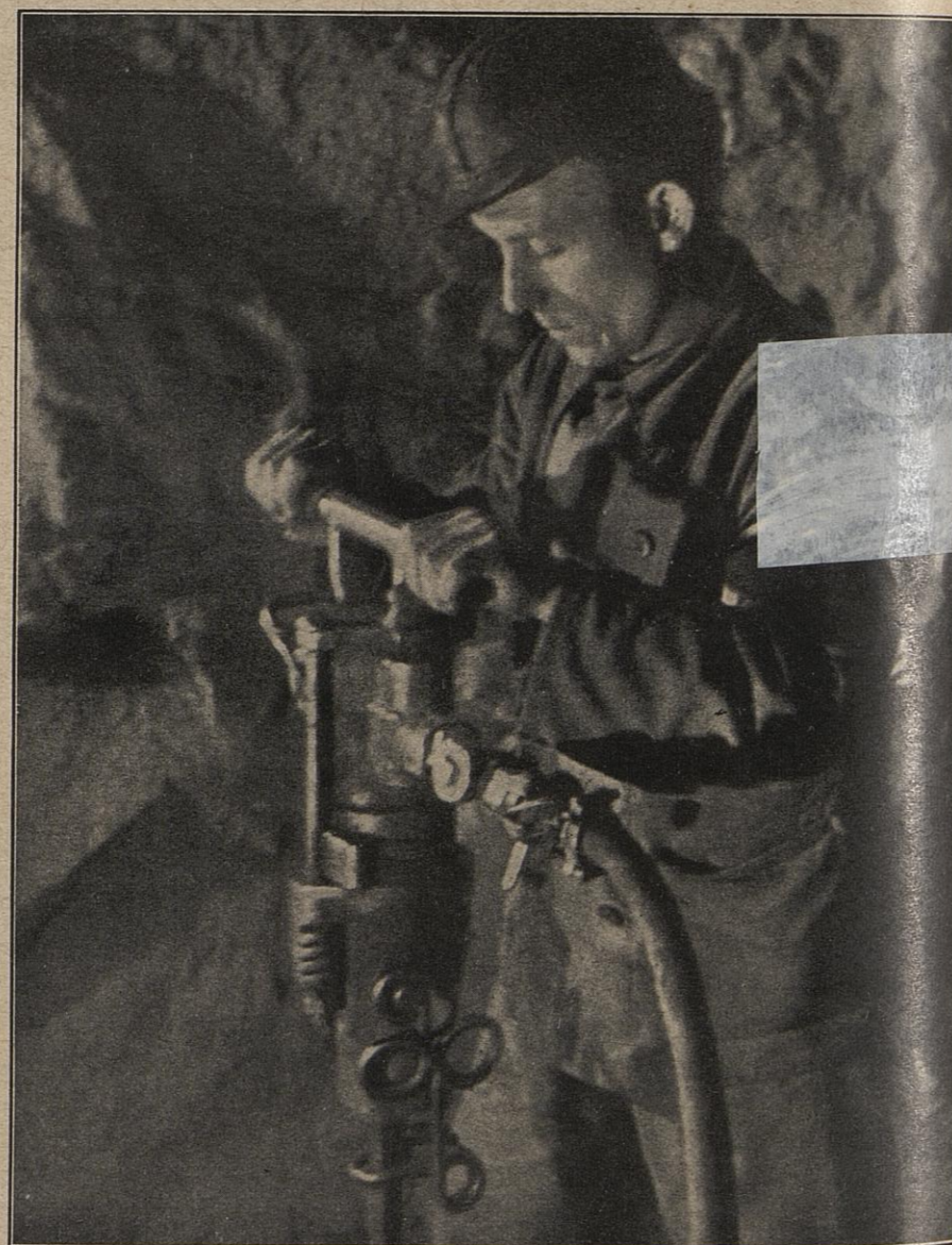
Bei der für einen Bergmann gewohnten Arbeit. Mit dem Presslufthammer gilt es einen tiefen Stollen in den Berg zu treiben, um die unterirdischen Verbindungen zwischen zwei Befestigungswerten herzustellen.
