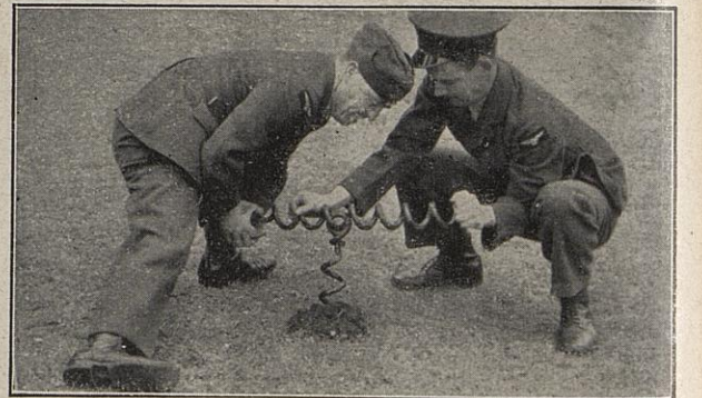
Im Garten hinter Downing Street Nr. 10 wird ein Anker für Seile in die Erde getrieben; an ihnen hängen... Ballons, die zur Londoner Ballonsperrung gehören.
