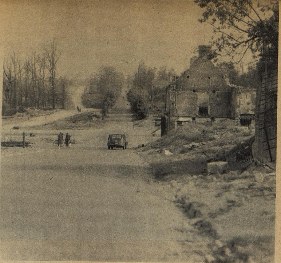
Au croisement de Tilly-sur-Seulles, cette route stratégique, un des éléments principaux du transport, établie par les Alliés à travers les clos normands, doublait la route nationale.
