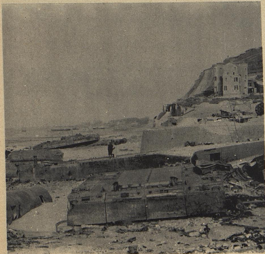
Sur la plage et la côte est d'Arromanches, un des éléments du fameux « mur de l'Atlantique », cale d'accès à la plage avec son ponton métallique de liaison à la digue flottante.
