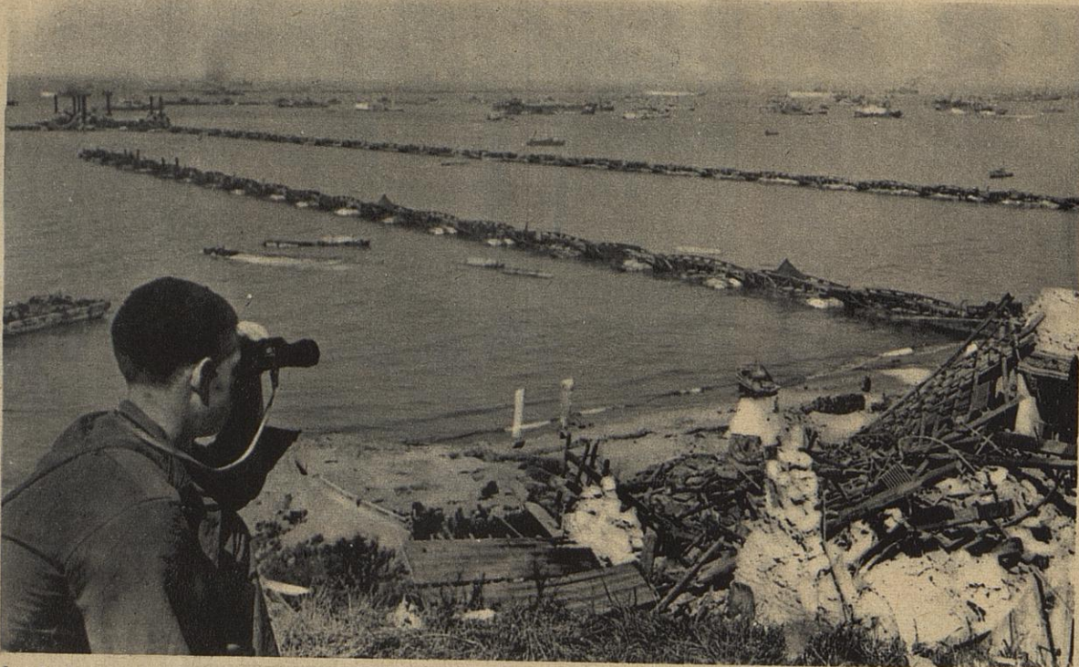
Les jetées des deux ports étaient constituées par de vieux navires délibérément sacrifiés. Les appontements, faits de caissons de béton, étaient conçus pour supporter un trafic de 12.000 tonnes et de 2.500 véhicules par jour pendant 90 jours.
