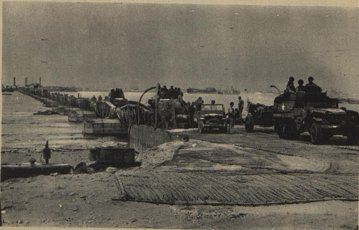
Les appontements furent montés directement dans l'eau à une allure record. A leur débouché sur le sol, des tapis métalliques facilitaient le passage des divers véhicules. Tout ceci avait fait l'objet d'une remarquable préparation.
