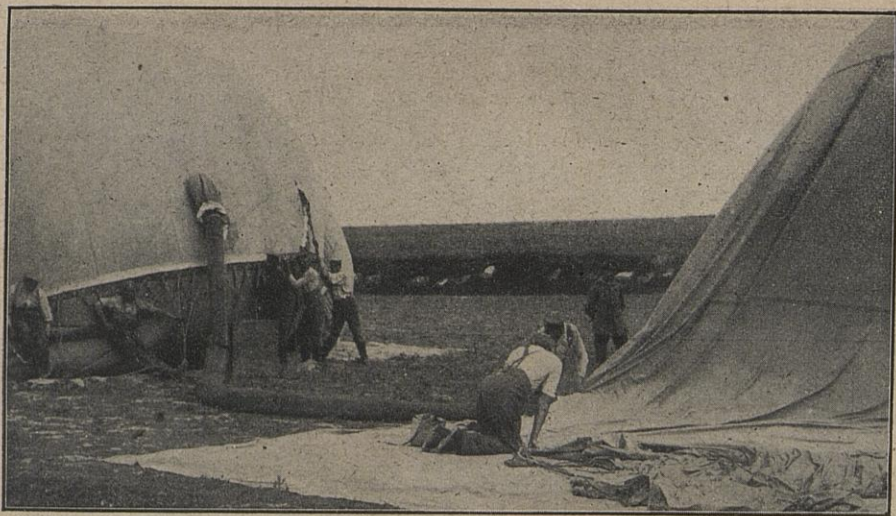
Bei den Feldluftschiffern: Das Gas eines beschädigten Ballons wird in einen Ersatz- Ballon umgedrückt.
