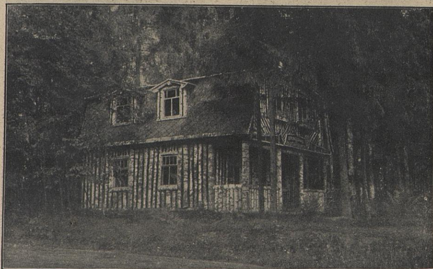
Fernsprechzentrale mit Zeichner- und Kartenzimmer. Von den Mannschaften einer Feldluftschiffer-Abteilung im Osten selbst gebaut.
