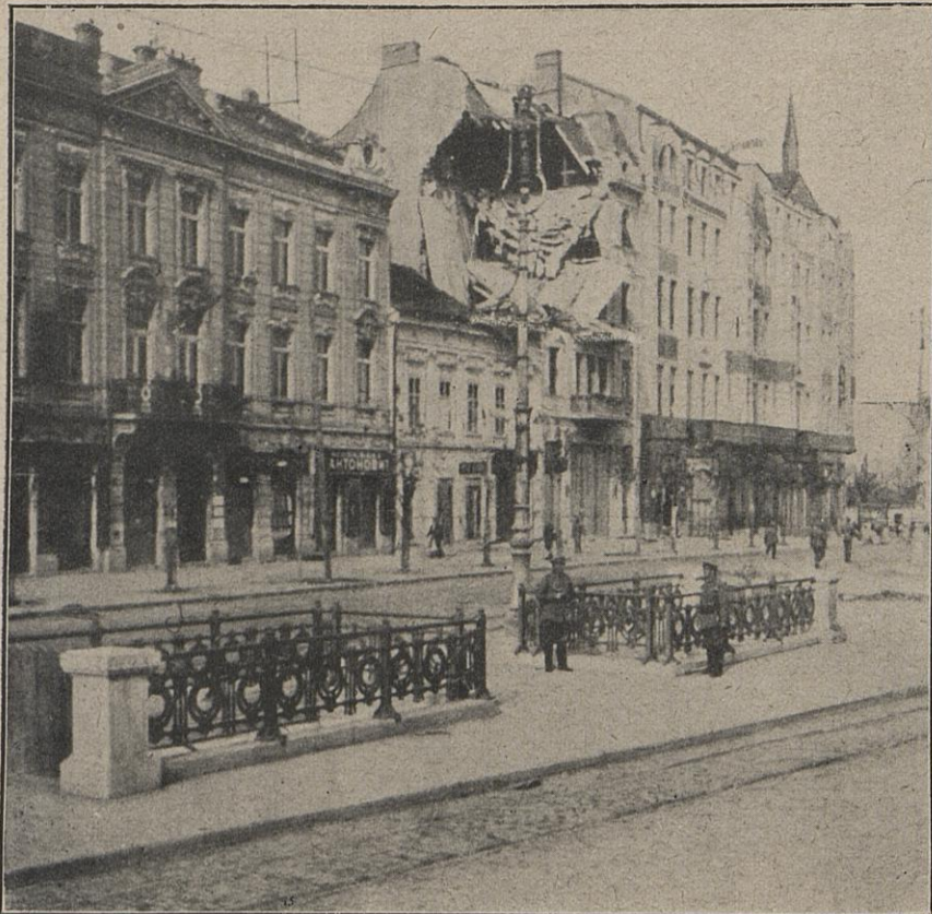
Granattreffer in einem Haus der Hauptstraße.
