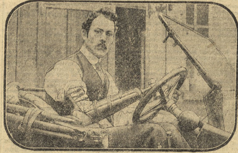
Grâce à un ingénieux dispositif, un amputé du bras droit peut exercer son métier de chauffeur d'automobile. Photo MEURISSE
