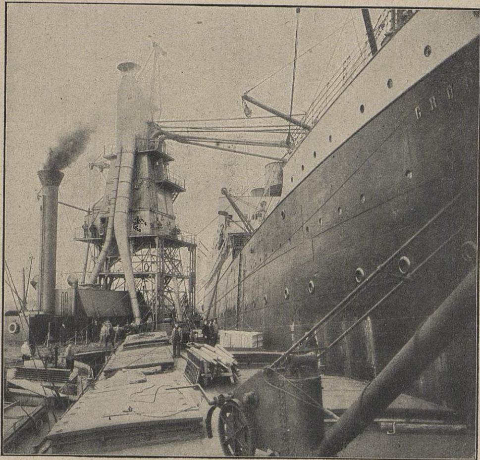
Die Verarbeitung der Ernte mit Hilfe Riesenmaschinen: Entladen eines Getreidedampfers durch eine Saugluft-Anlage. Erbaut von Amme, Giesecke & Konegen A. G., Braunschweig.
