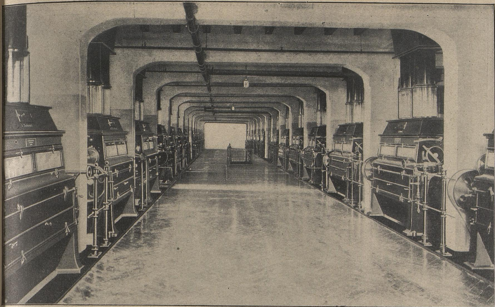
Die moderne Mühle ohne die geringste Spur von Mehlstaub. Man beachte den Parkettboden! In dieser süddeutschen Groß-Mühle wird das Mehl zwischen Walzen gemahlen. Anlage von Amme, Giescke & Konegen A. G. Braunschweig.
