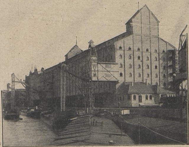
Kombinierte Silo- und Bodenspeicher-Anlagen in Ludwigshafen a. Rh., Fassungsvermögen etwa 25,000 Tonnen. Ausgeführt für die bayr. Staatsbahn von der G. Luther A.-G., Braunschweig.
