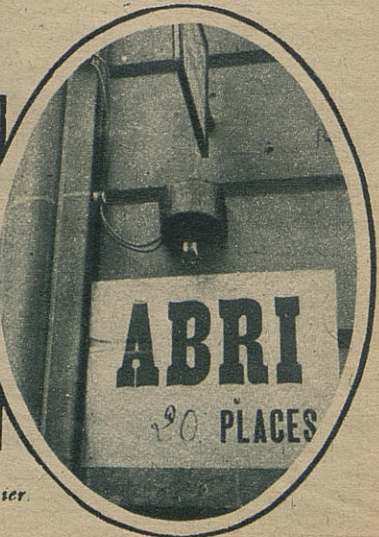
Un avis d'abri dans une maison avec son fanal électrique.
