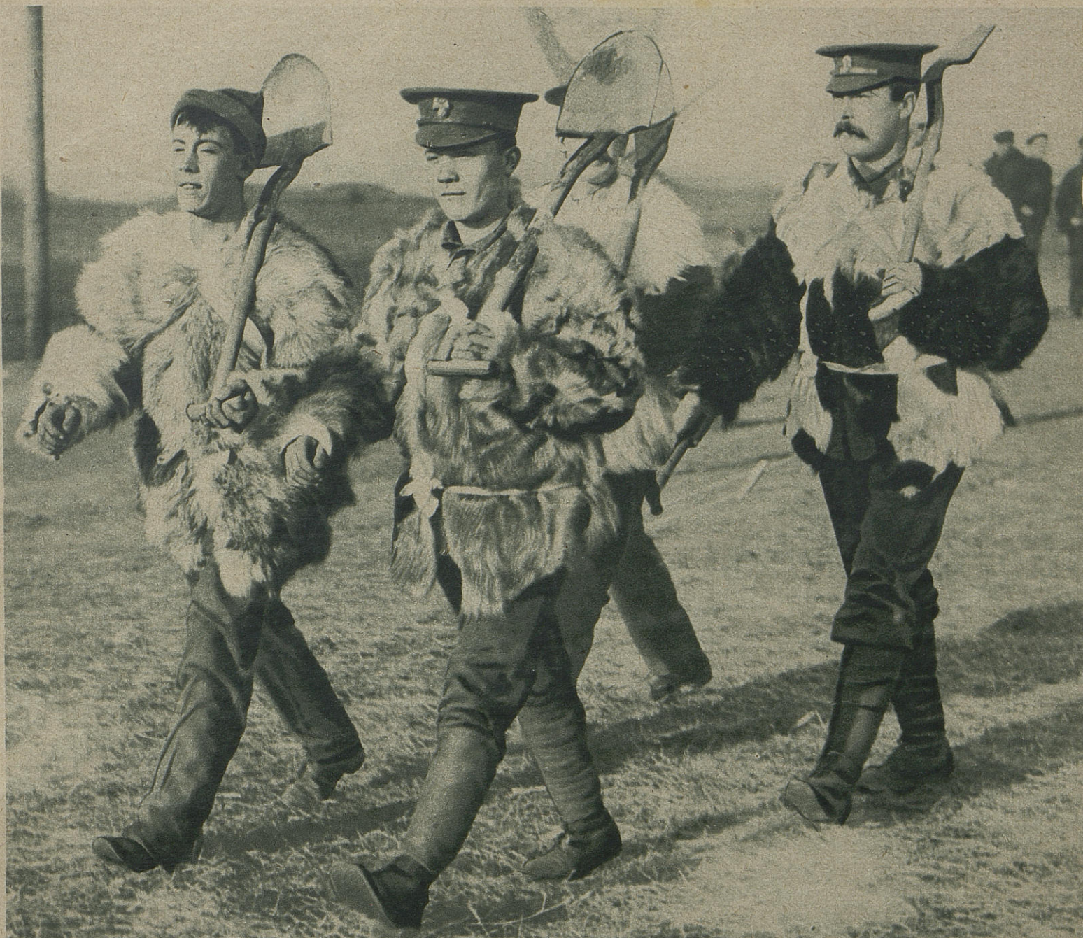
LES " TOMMY " S'EN VONT CREUSER DES TRANCHÉES
