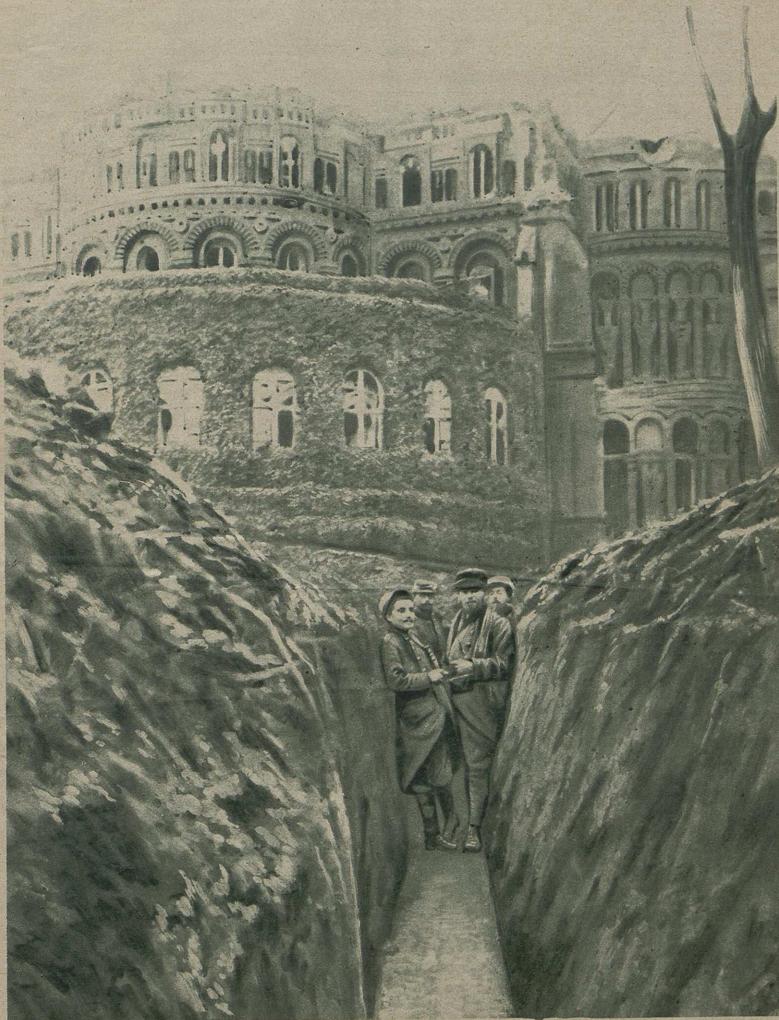
UNE LIGNE DE TRANCHÉES DANS UN PARC
