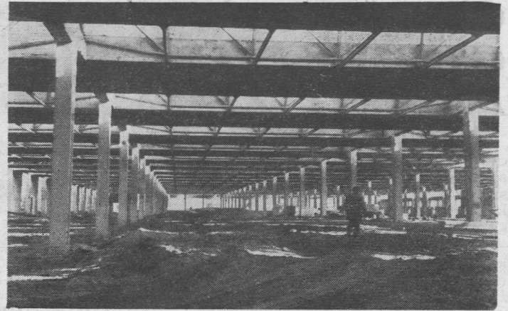
Sur le chantier de la future usine de pneus pour automobiles à Olsztyn, dans le nord de la Pologne, les travaux avancent rapidement. Cet atelier n'est pas encore terminé mais dans d'autres on a déjà commencé le montage des premières machines et installations. Bientôt l'usine commencera à produire
