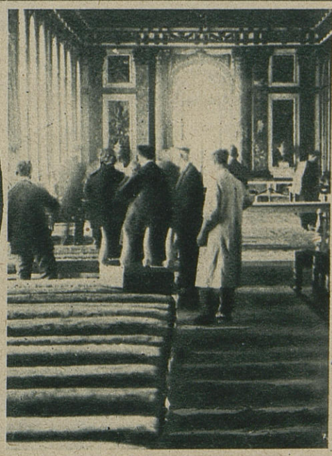
L'installation des petites tables et des bancs.
