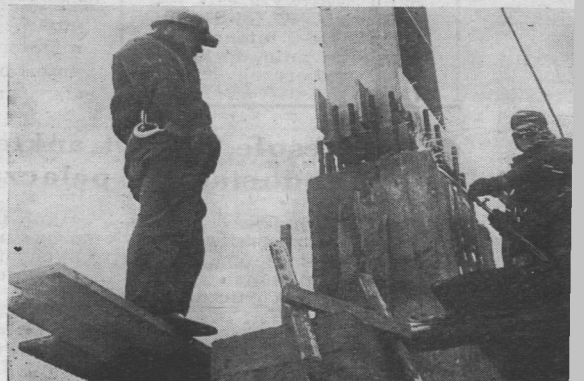
Budowa: beton, stal, elektryczność
