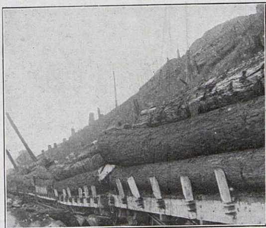
Il faut des trucs spéciaux pour le chargement de ces fûts colossaux sous le poids desquels s'effondreraient des wagons ordinaires.
