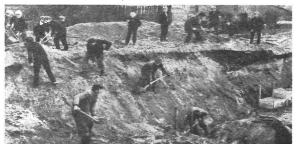
W tym miejscu stanie dom mieszkalny dla nauczycieli. W przygotowaniu terenu pomagają uczniowie
