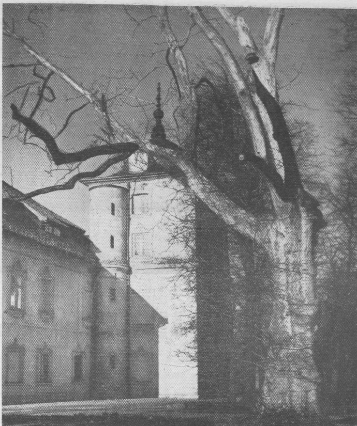
Pałac w Nieborowie od strony ogrodu francuskiego.
