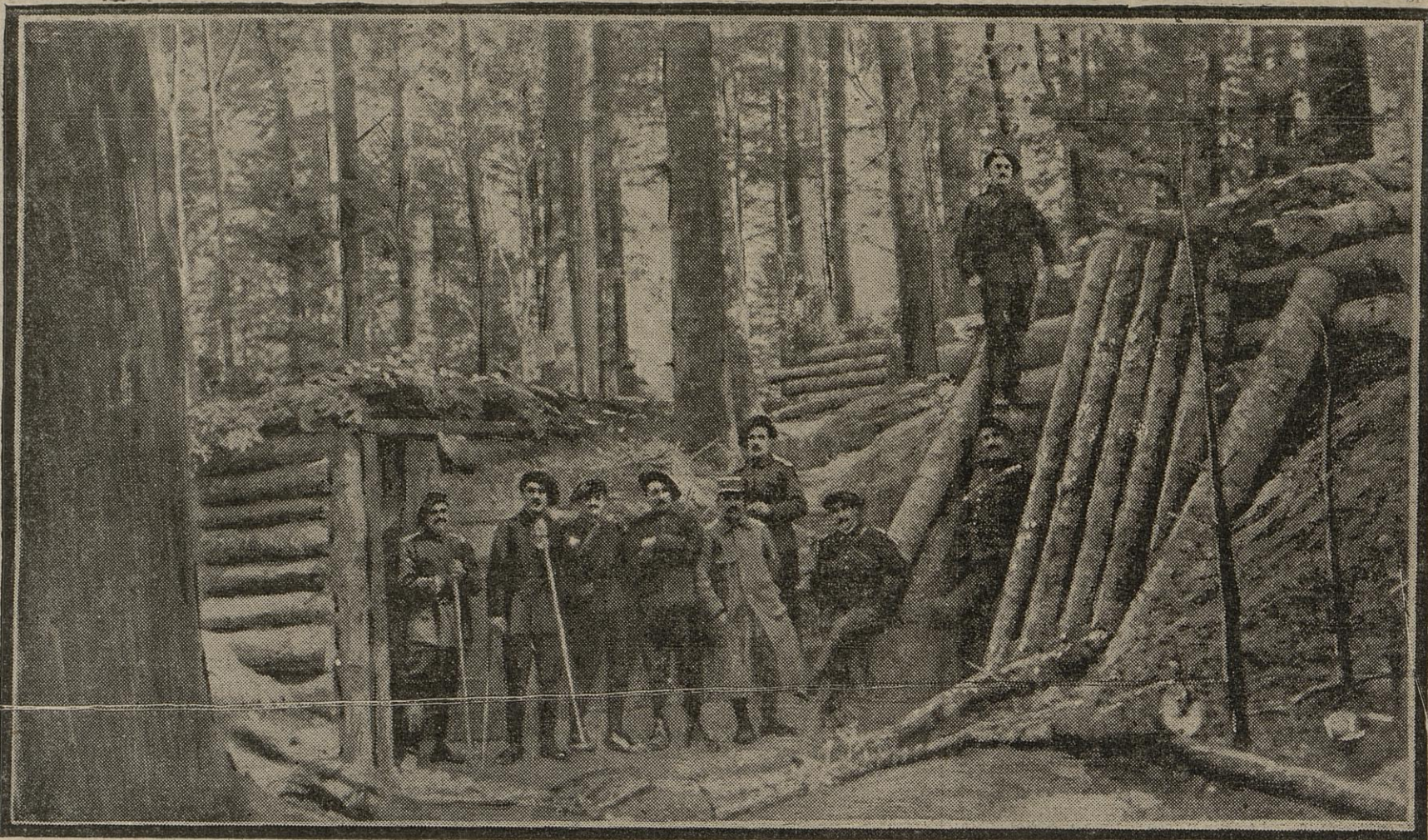
La nature si pittoresque et si mouvementée des régions alsaciennes où nous progressons et nous consolidons tous les jours procure à nos braves l'occasion d'aménager des abris très confortables, où les matériaux essentiels sont les troncs d'arbres dont, de temps immémorial, les bûcherons se servent pour architecturer leurs gîtes forestiers.
